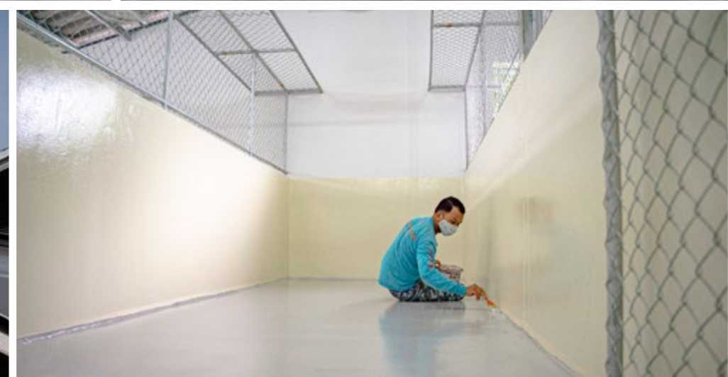
อาคารทำหมันอยู่ระหว่างการต่อเติมส่วนขยาย
